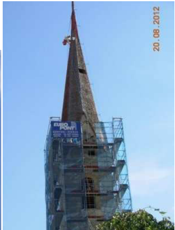
Arbeiten in luftiger Höhe, Ausbesserungs- und Malerarbeiten an den Schindeln
