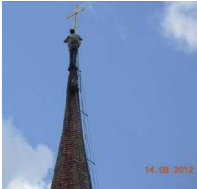
Arbeiten in luftiger Höhe, Ausbesserungs- und Malerarbeiten an den Schindeln
